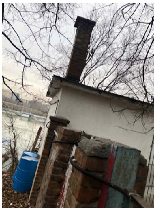
8. kémény téglakötések felülvizsgálata, habarcspótlása javasolt.
